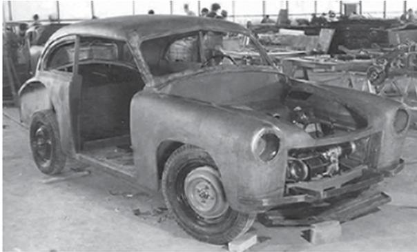
Foto 5. Chasis, carrocería en chapa y motor (*Coche a la Vista* 1952).
